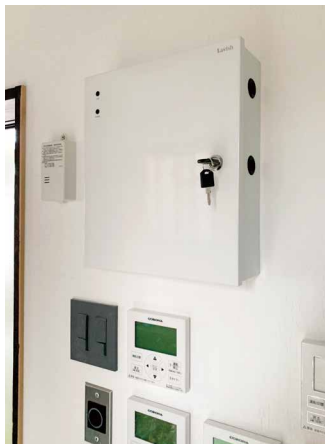
管理入室 (LOE-A180L / BR-A180ZL / RER-SKX2EHM / EX-H5-J) (POSR-B3B / COA-22) 管理入室には露出型の電磁錠を設置。また、制御器をこちらに設置することで、管理室パソコンから扉の操作を行うことも可能です。
