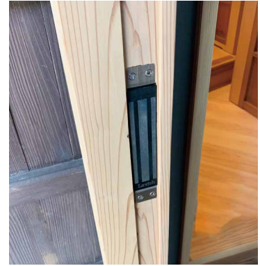
玄関 (LOEU-E180L / BR-U180 / RER-SKX2EHM / EX-H5-J) : リーダーにRER-SKX2EHM、解錠ボタンにEX-H5-J、電磁錠は扉枠と戸への埋込設置で建物の趣を壊しません。
