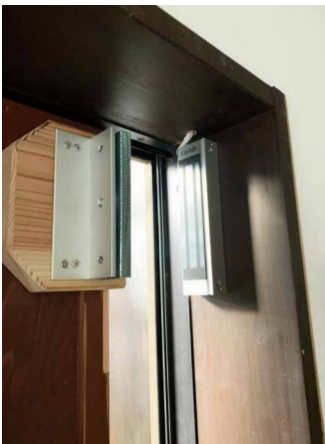
管理入室 (LOE-A180L / BR-A180ZL / RER-SKX2EHM / EX-H5-J) (POSR-B3B / COA-22) 管理入室には露出型の電磁錠を設置。また、制御器をこちらに設置することで、管理室パソコンから扉の操作を行うことも可能です。
